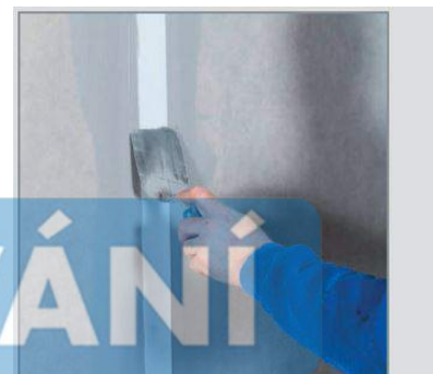
Krok 3: Přitlačte výztužnou pásku Knauf Kurt na spáru.
