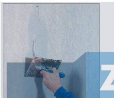
Krok 1: Vyplňte spáru systémovým tmelem Drystar-Filler
