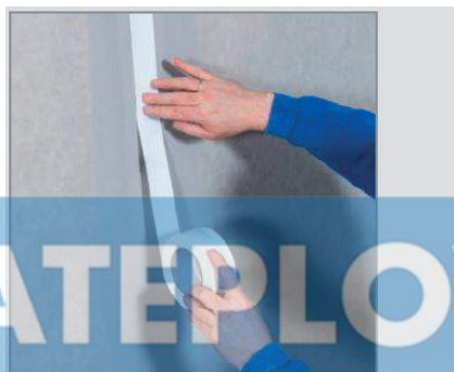
Krok 2: Spojte desek překryjte výztužnou páskou Knauf Kurt.
